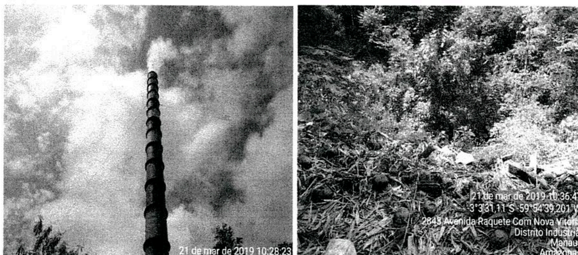
Fig.6 e 7 Fumaça esbranquiçada saindo da chaminé e área de encosta da empresa.
