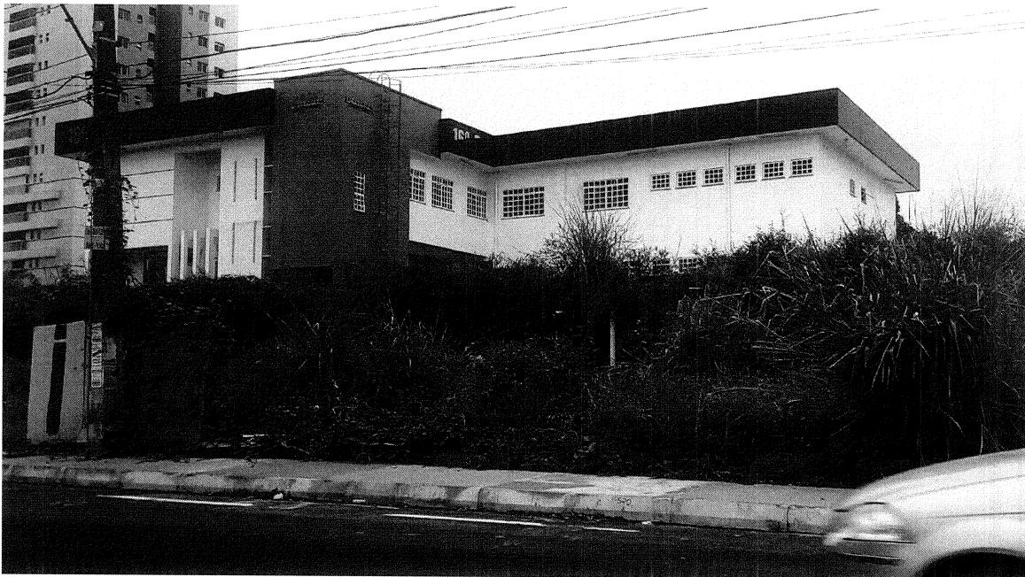
Sinais de abandono: vegetação já cerca o terreno. Vista pela Av. Láctea.
