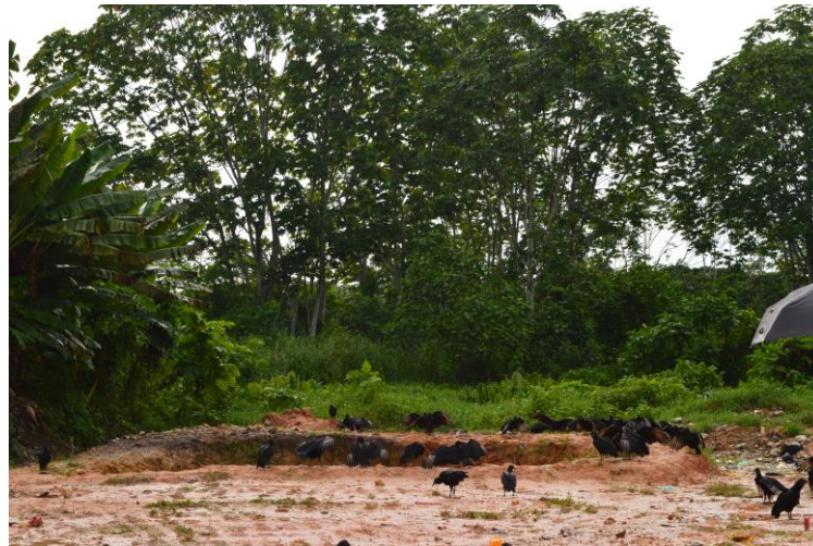
Vala destinada ao depósito de RSSS, entretanto, está disposta irregularmente por ser permeabilizante e está a céu aberto.
