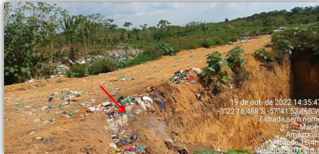
Fumaça saindo dos resíduos depositados no vazadouro.
