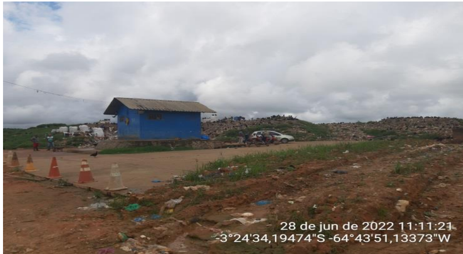
Vista da Guarita e entrada do Vazadouro (Lixão)
