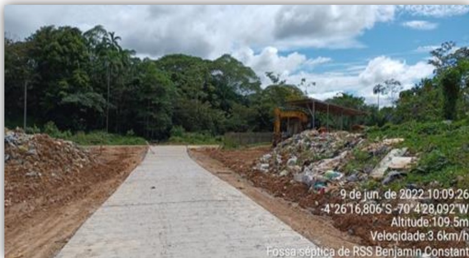
Acesso pavimentado do Vazadouro.
