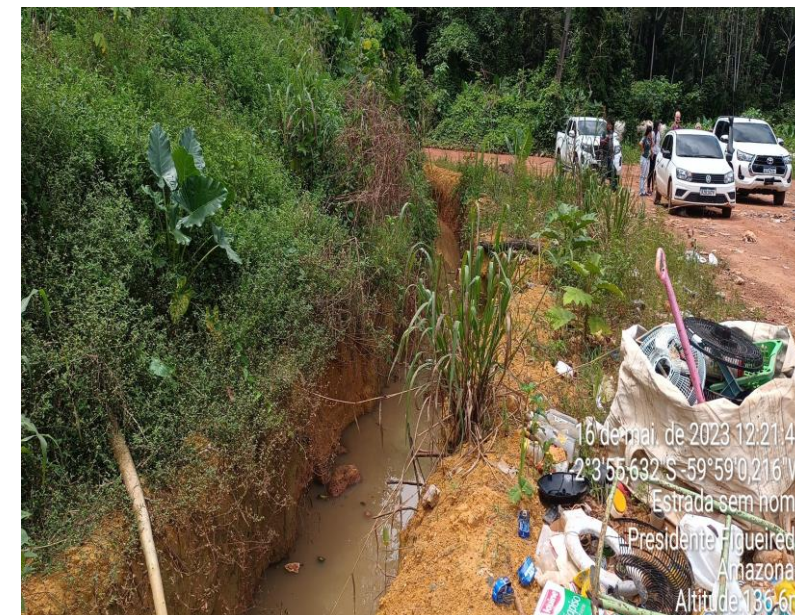
Valas abertas para a retirada de águas superficiais e líquidos lixiviados que fluem do maciço de RSU.
