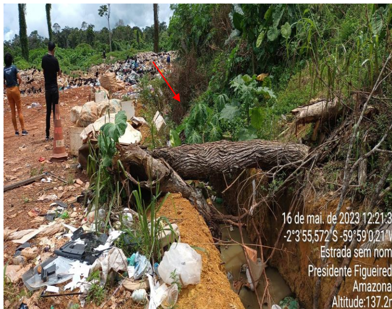
Valas abertas para a retirada de águas superficiais e líquidos lixiviados que fluem do maciço de RSU.
