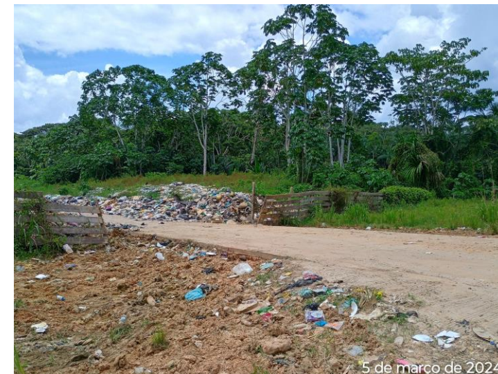
Área de acesso ao vazadouro, as pilhas atualmente se encontram dispostas da entrada até aos fundos do vazadouro, já não existe porteira para evitar o acesso de terceiros, somente parte de um cercamento como forma de delimitá-lo.
