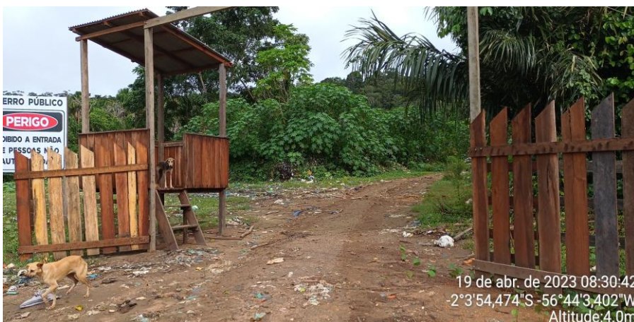
Pequena infraestrutura para controle do acesso de terceiros ao interior do vazadouro, portão e pequena guarita, onde não fica ninguém para coibir a entrada de possíveis catadores.
