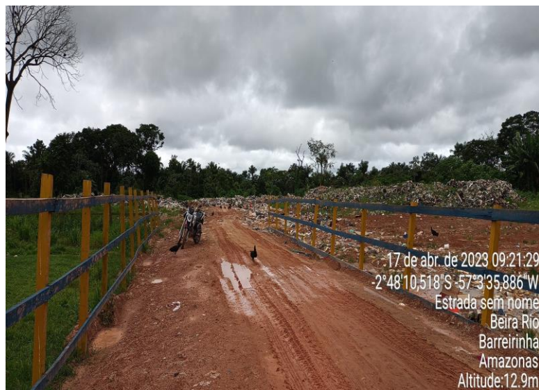
Vista frontal do vazadouro, dotado de cercamento.
